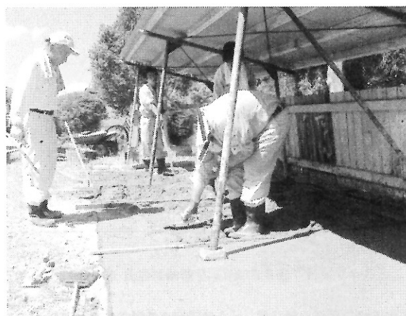
T科 施工実習
