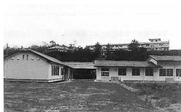
測量実習棟と造園実習棟
